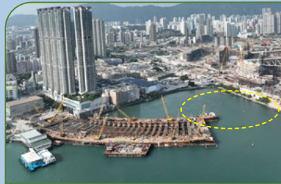
第二期中九龙干线临时填海 (2022年11月): 第一期(即右边圆圈位置) 的临时构筑物已拆除, 并将海床还原
