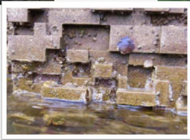
Eco-tiles 生態方塊
